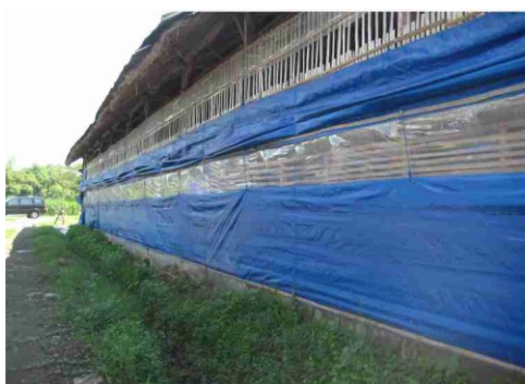
Gambar 1. Kandang closed house menggunakan kandang yang telah ada
